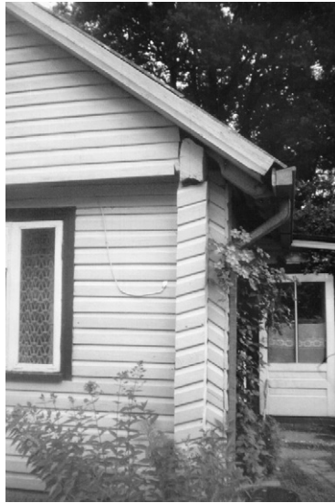
14 pav. Gyvenamojo namo kampas: sijų sunėrimas. Pastatas statytas 1917 m. Jono Staugaičio, V. Endriukaičio sodyba, Leliokiškės k.
