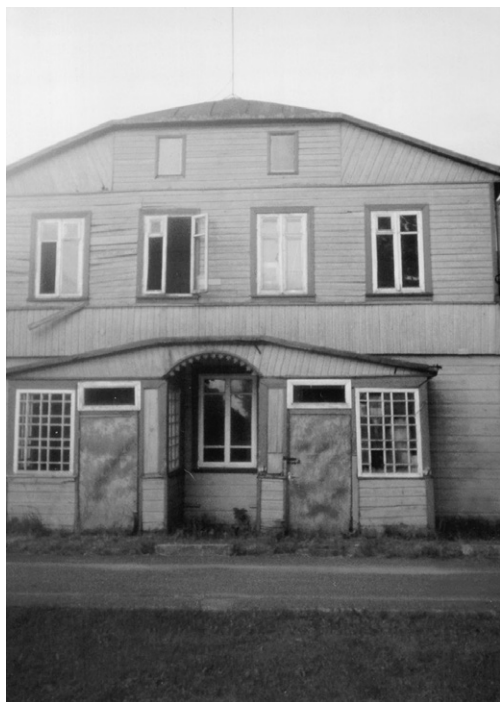
27 pav. Špitolė (prieangis ir mansarda). Griškabūdis
