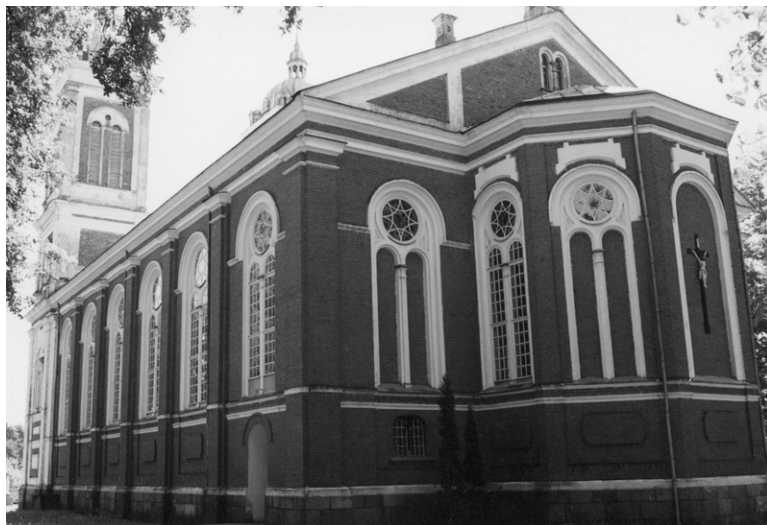
Bažnyčios šoninis ir galinis fasadai. 2002 m. E. Juškos nuotr.
