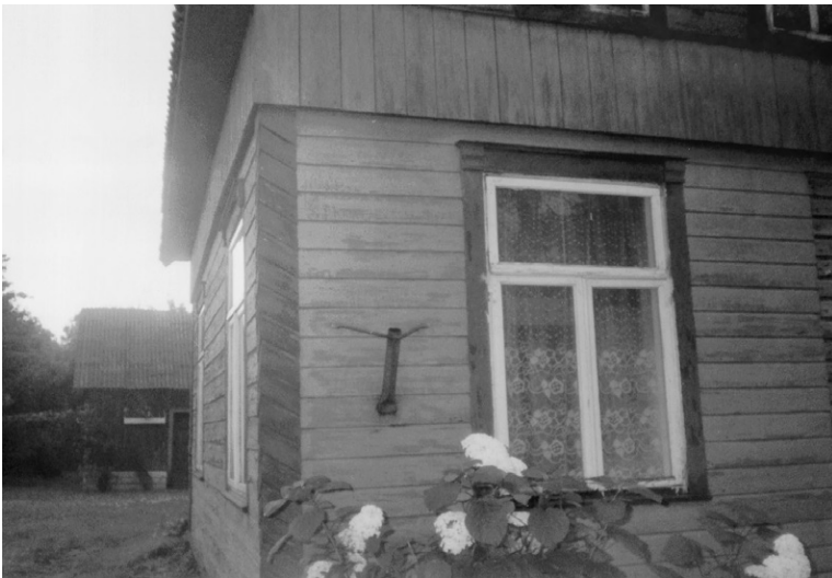
16 pav. Gyvenamojo namo kampo apkalimas. Namas statytas apie XX a. meistro Sutkaus, kuris tame name ir gyveno, Paluobių bažnytkaimis
