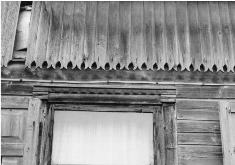
17 pav. Ertikio lentų išpjaustymas ir lango dekoras. Buvęs meistro J. Valaičio gyvenamasis namas, statytas jo paties apie 1939 m. Jablonskio g. 11, Griškabūdis
