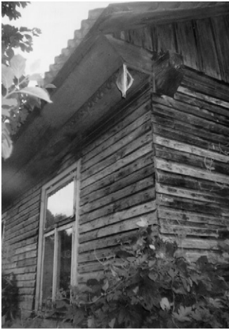
5 pav. Gyvenamojo namo pastogė – profiliuotų gegnių ir skersinių sijų derinys. Buvęs Jakaičių gyvenamasis namas. Patašinės k.
