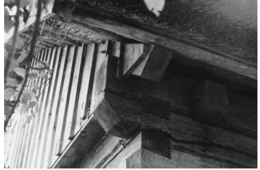
38 pav. Klėties pastogės kampas, gegnių ir skersinių sijų konstrukcija. Rygiškių k., J. Jablonskio muziejus
