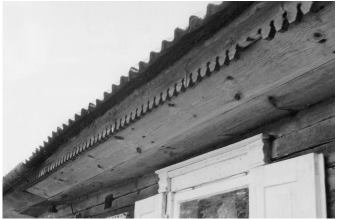
5 pav. Gyvenamojo namo pastogė – profiliuotų gegnių ir skersinių sijų derinys. Buvęs Jakaičių gyvenamasis namas. Patašinės k.
