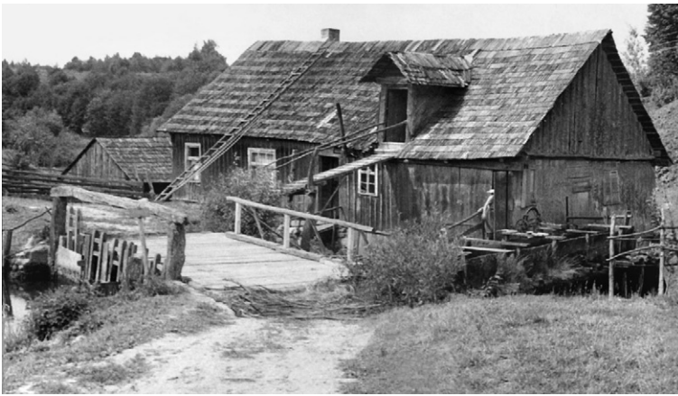
10 pav. Gražjūrio malūno pylimas – kelio tiltas. 1967 m. Iš LEI hidrologijos laboratorijos archyvo
